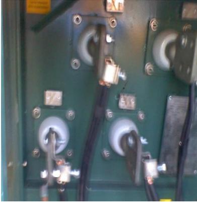
FIGURA 5: Salidas de baja tensión "X".
