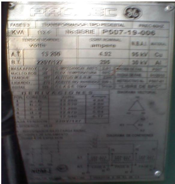
FIGURA 6: Placa de datos del transformador.
