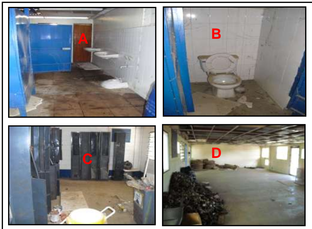
Imagen: 5.4. Descripción de los espacios inhabilitados del taller de VHPC Fuente: Elaboración propia
