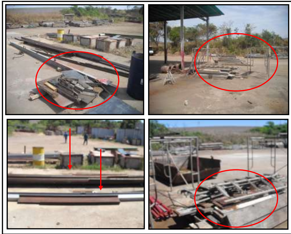
Imagen: 5.12. Ubicación de los materiales de fabricación y soldadura Fuente: Elaboración propia
