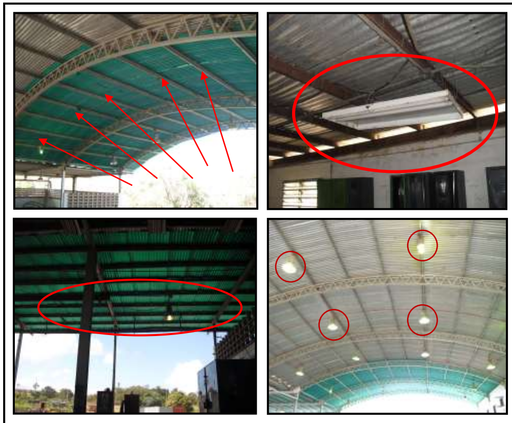
Imagen: 5.3. Descripción de la iluminación del taller de VHPC Fuente: Elaboración propia
