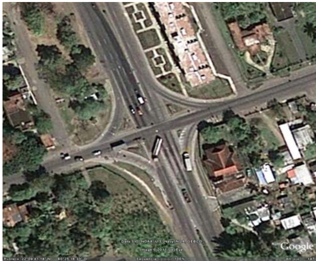
Figura 2.2 Vista general de la intersección ave 64 y circunvalación
