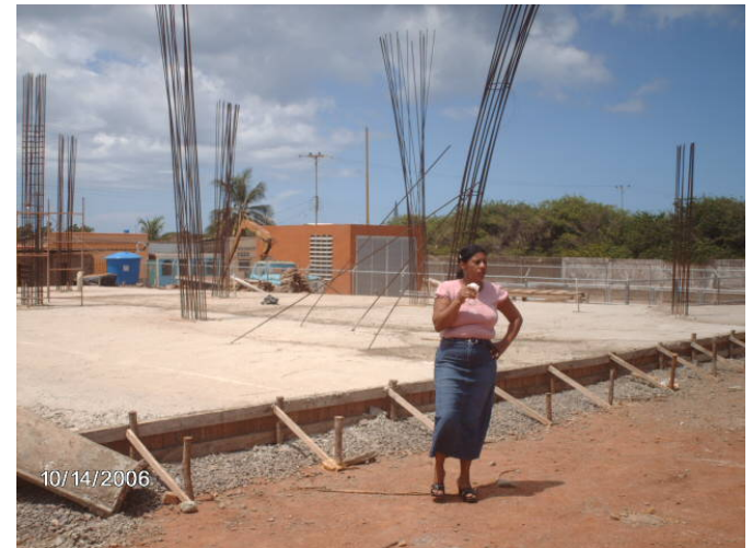
Morro de Puerto Santo. Area de construcción de la estructura física del Centro Endógeno Pesquero
