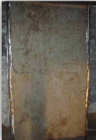
Figura 35: Placas de acero inoxidable instalada en la falda del reactor R40
