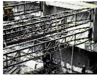
Excavación apuntalada con cerchas metálicas
