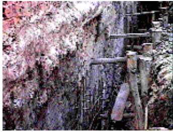
Excavación apuntalada con madera
