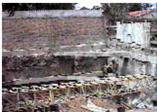
Cercha metálica con puntales
