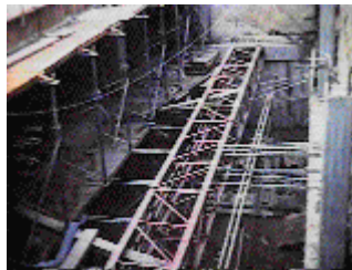
Excavación apuntalada con vigas metálicas
