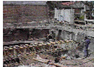
Cercha metálica como modo de apuntalamiento
