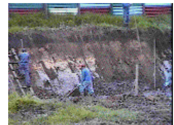
Perfeccionamiento del talud de excavación
