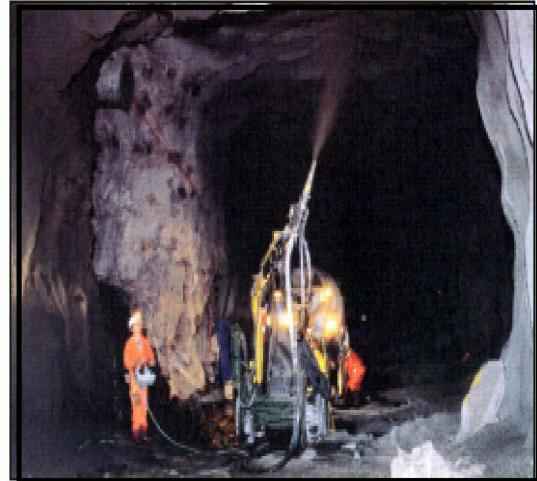
Sostenimiento de labores subterráneas (Doe Run Perú)
