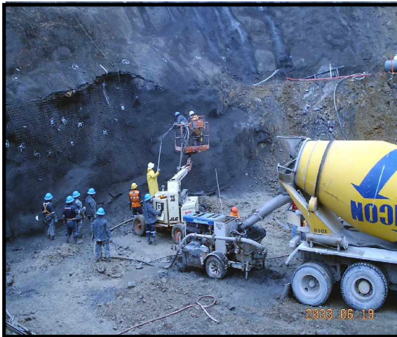
Sostenimiento de taludes en mina Open pit (Antamina)
