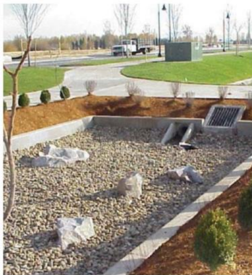
Figura 11 - Bacias de percolação (Portland, 2002) Fonte: CANHOLI (2005, p.43)
