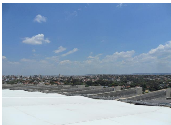
Figura 17 – Lona da cobertura
