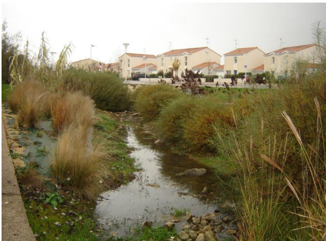
Figura 14 - Bacia de retenção na cidade de Lagord, região de Poitou-Charentes, França Fonte: REZENDE(2010, p. 23)
