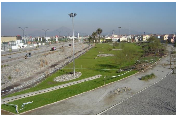
Figura 15 - Bacia de detenção em Santiago, Chile. Fonte: REZENDE (2010, p. 22)
