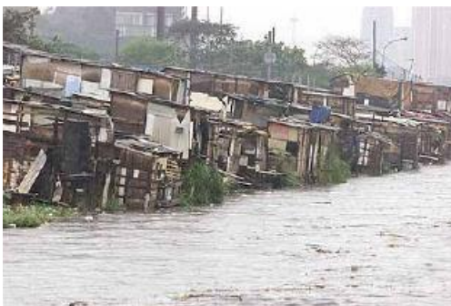
Figura 2- Cenário de risco associado a enchentes e inundações com alta energia de escoamento envolvendo assentamentos ribeirinhos de padrão construtivo precário
