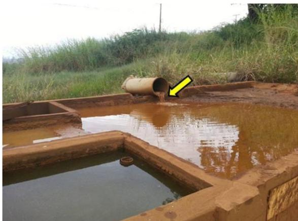
**Figura 23:** Tanque separador de água e óleo da indústria X.
